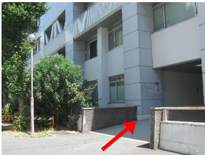
④こちらから基礎研究棟に入ります。
